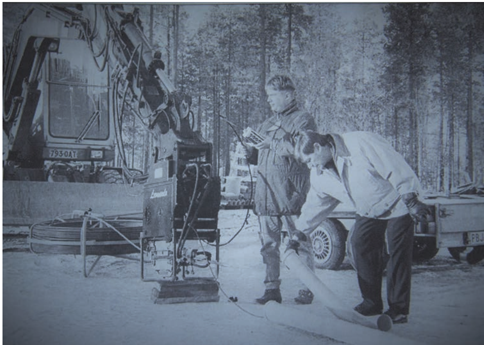
Seppo (vas.) ja Juho Krekola esittelevät tekniikkaa, millä kaapelit voidaan ujuttaa maanlaiseen putkistoon.
