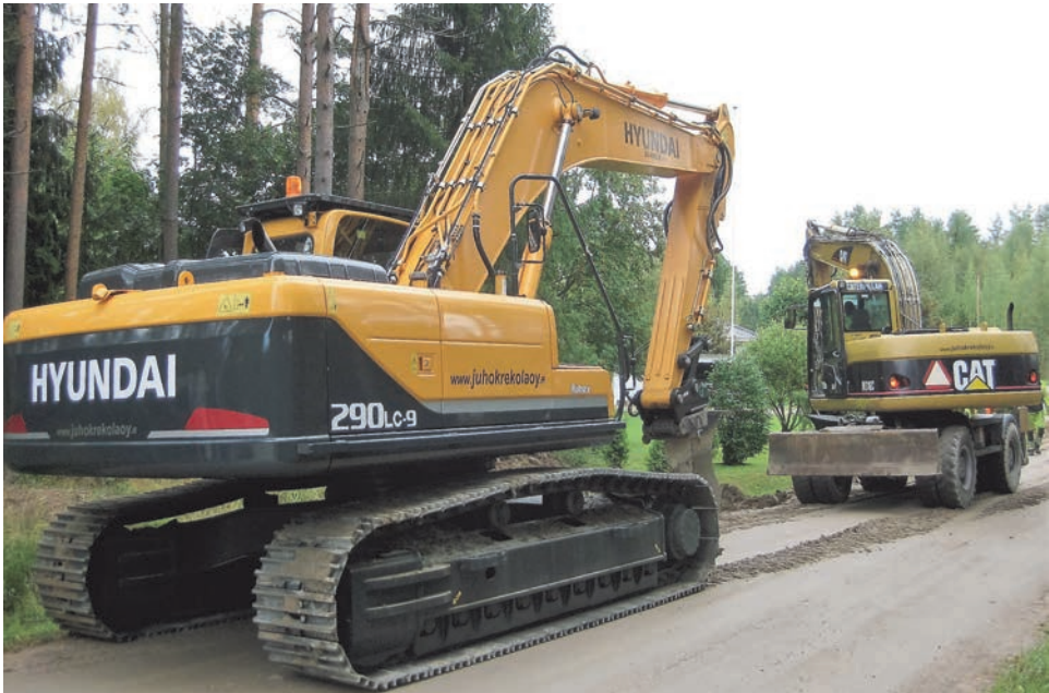
Hyundai sekä Cat Anvian kaapeliurauksessa Kurikassa.
