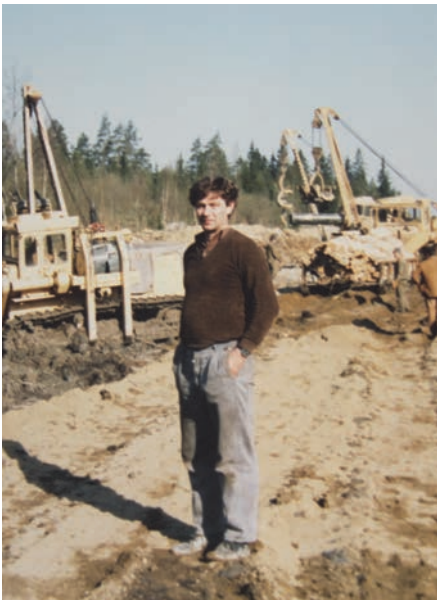
Juho Krekola Hyvinkää - Lempäälä maakaasulinjatyömaalla.
