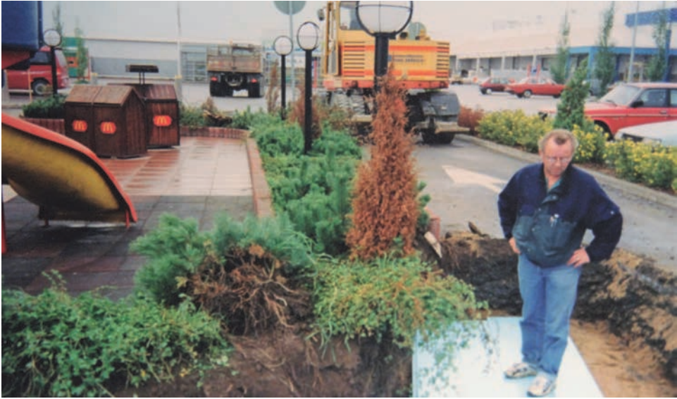
Mc Donalds Joupissa sai routaeristyksen. Työtä valvomassa rakennusmestari Toivo Keski-Saari.
