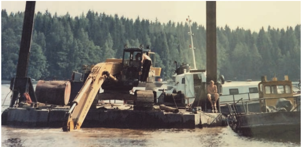
Komatsu työssään Muroleen kanavan ruoppaustyömaalla.
