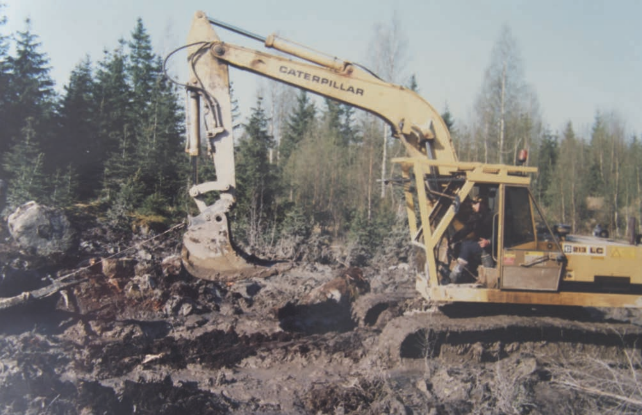
Krekolan Catepillar Hyvinkää - Lempäälä maakaasutyömaalla vuonna 1985.
