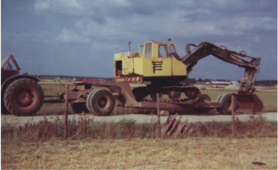
Työkoneita siirrettiin paikasta toiseen omalla traktorivetoisella lavetilla.
