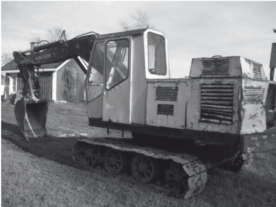
Pitkämön tekoallastyömaata varten hankittiin uusi 14 tonnin painoinen Fiskars 550 kaivinkone vuonna 1971.
