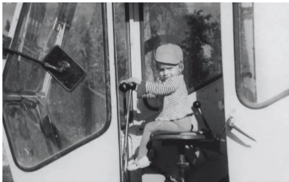
Nuorena on vitsa väännettävä. Runsaan vuoden ikäinen Seppo kaivinkoneen ohjaimissa.
