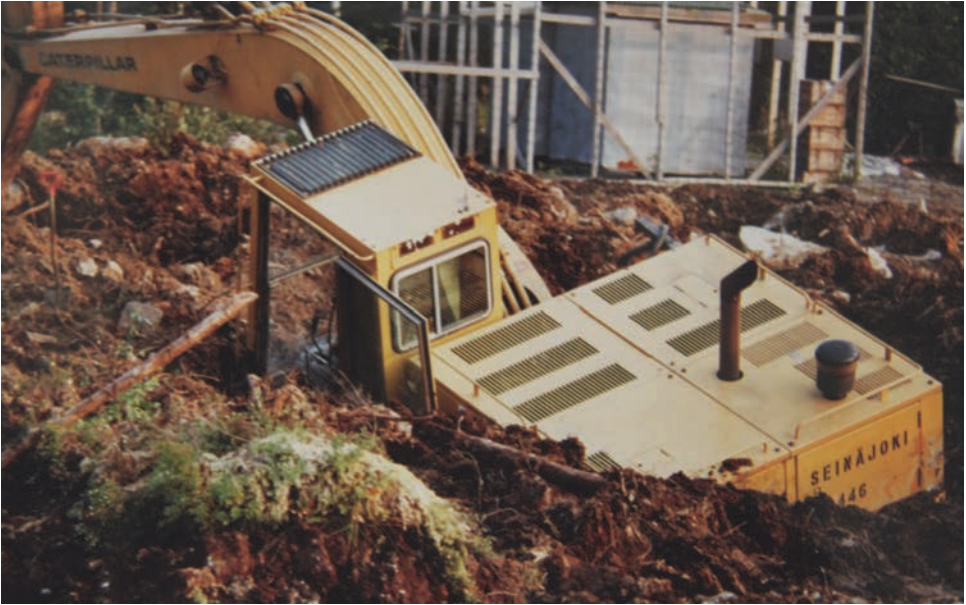
Catepillar upposi suohon Halkosaaren työmaalla.
