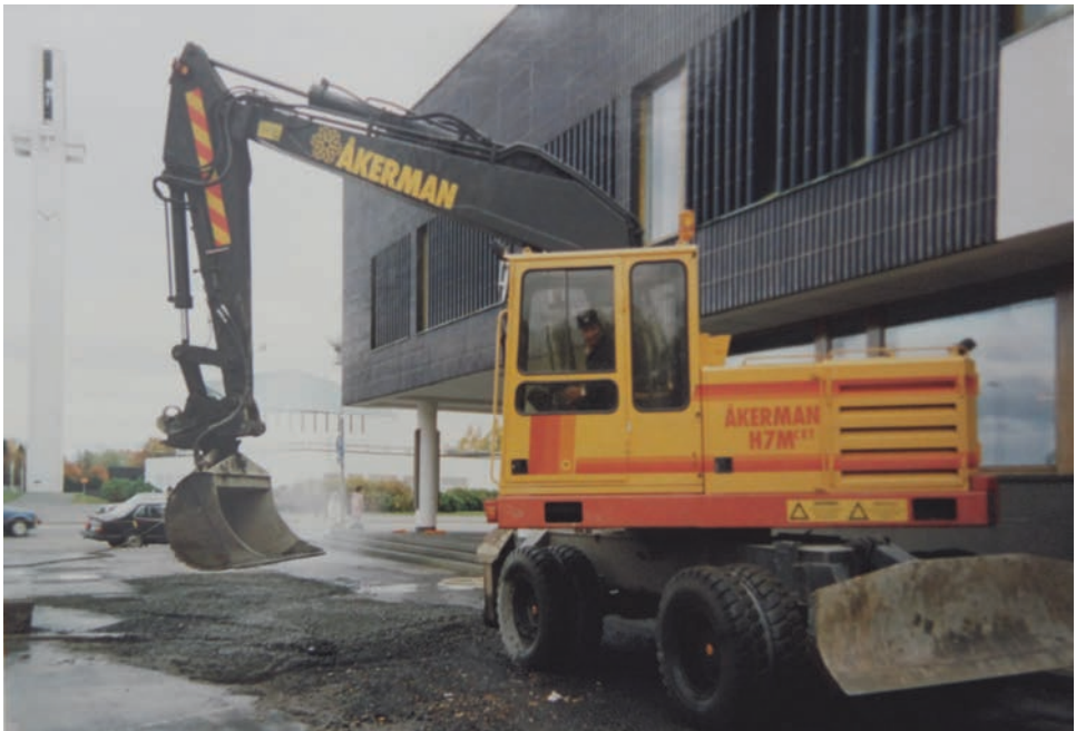
Seinäjoen kaupungin työtehtävät alkoivat työllistää Krekolaa 2000-luvulla. Tässä kaivuri kaupungintalon asfaltointitöissä.
