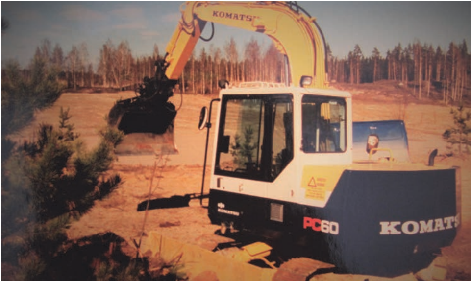
Japanilaismallinen Komatsu työmaalla.
